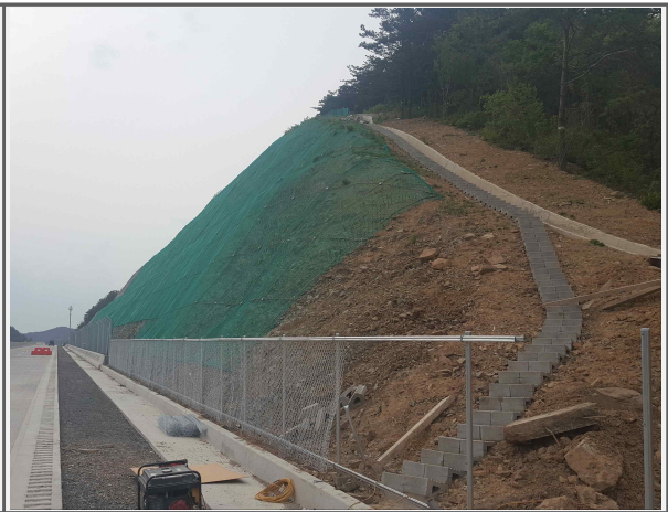
② 절토사면 시공 현황(중점 횡단)
