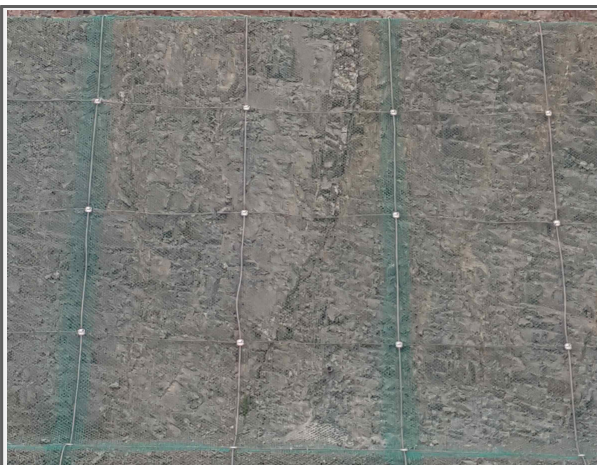
③ Sta.3+380부근(상주) 암맥의 관입 관측
